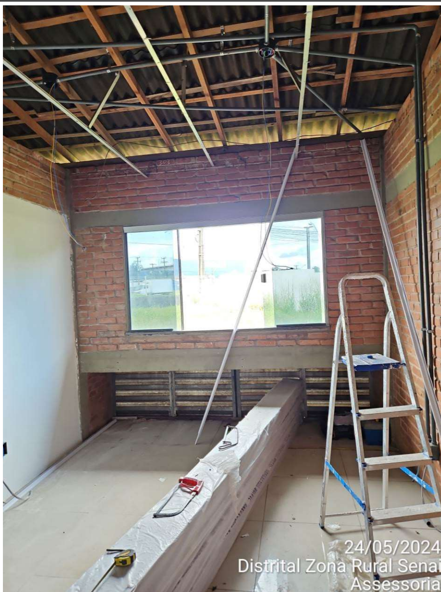
Foto 33 - Vista da obra
