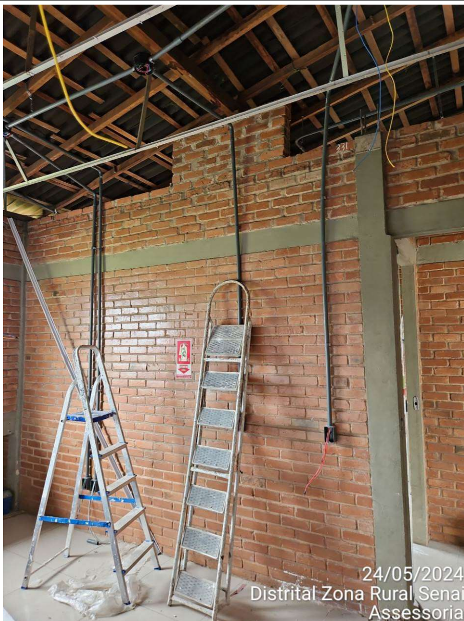
Foto 34 - Vista da obra
