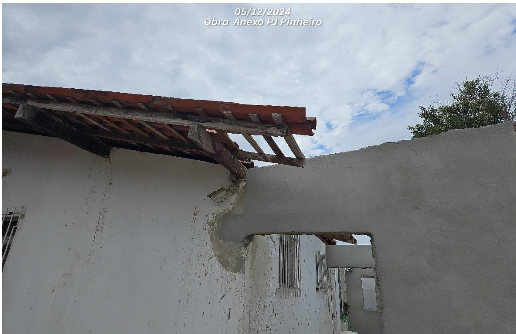
FOTO 2 – Ligação entre os dois prédios.
