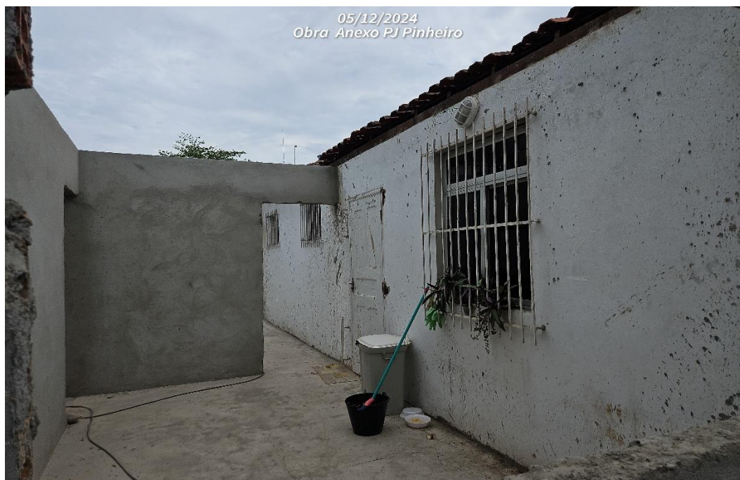
FOTO 5 – Parte interna do anexo.
