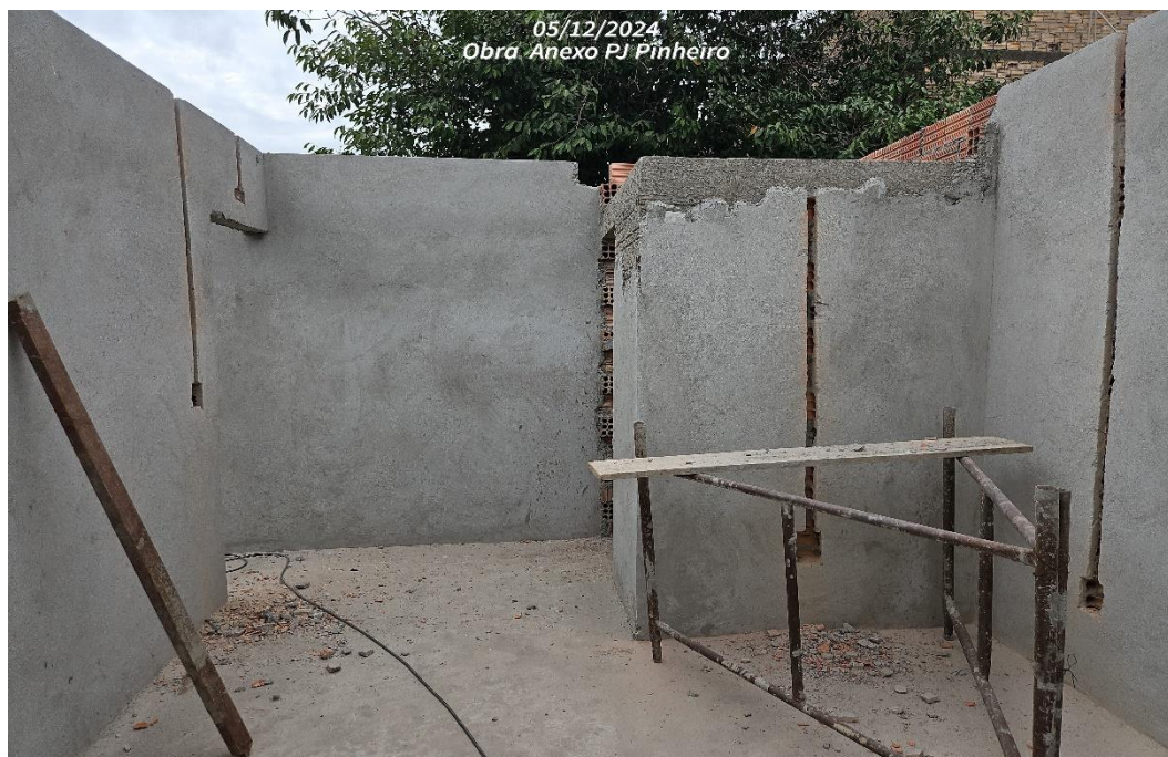
FOTO 3 – Parte interna do anexo.
