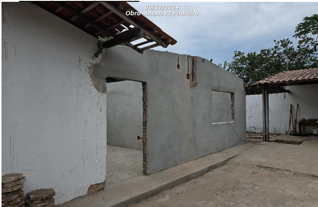
FOTO 1 – Anexo da promotoria em execução.
