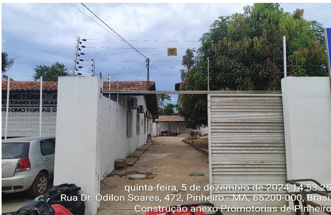
FOTO 10 – Portão de acesso ao anexo.
