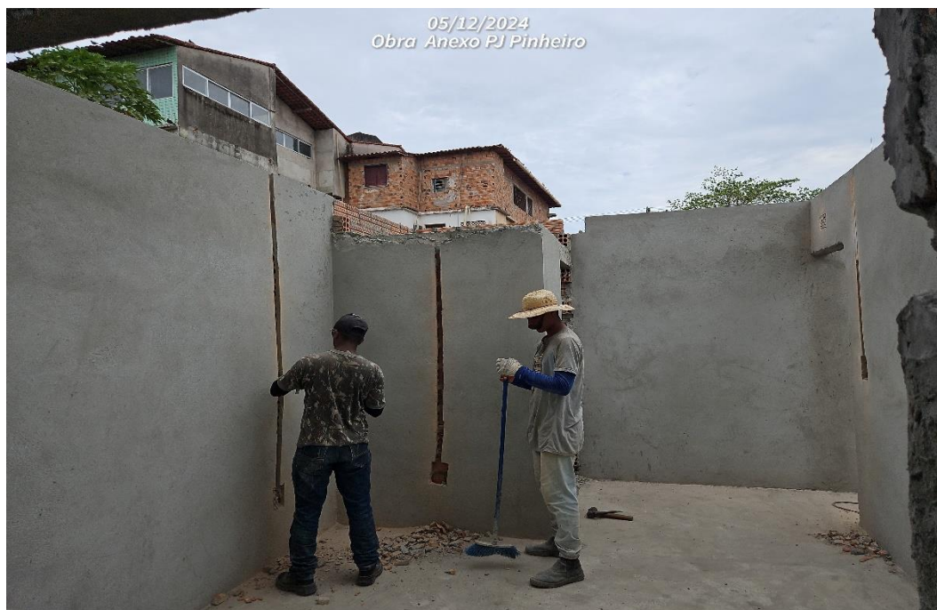
FOTO 6 – Serviço de corte para tubulação elétrica em execução.
