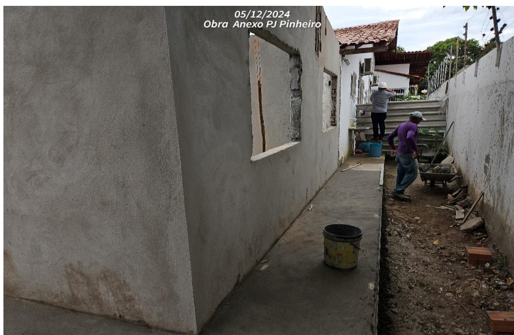
FOTO 4 – Parte de trás do anexo.
