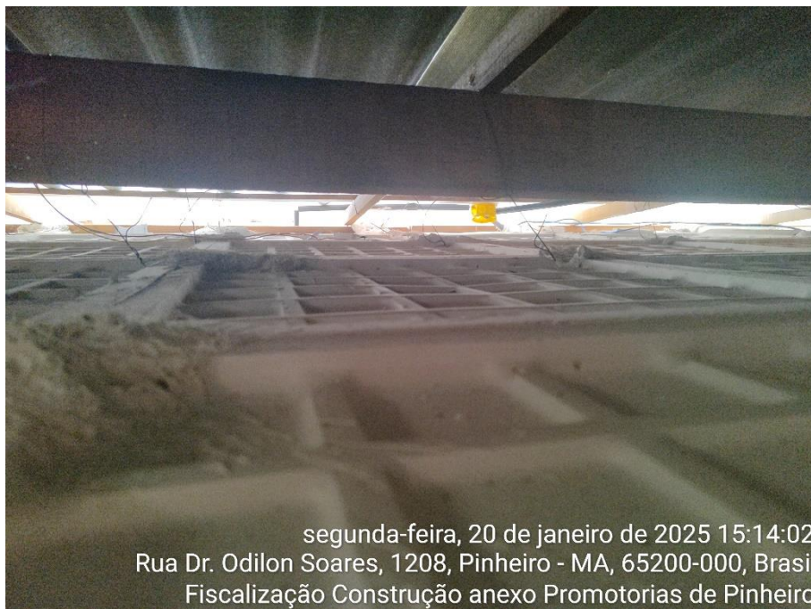
FOTO 19 – Conexões imperfeitas nos eletrodutos
