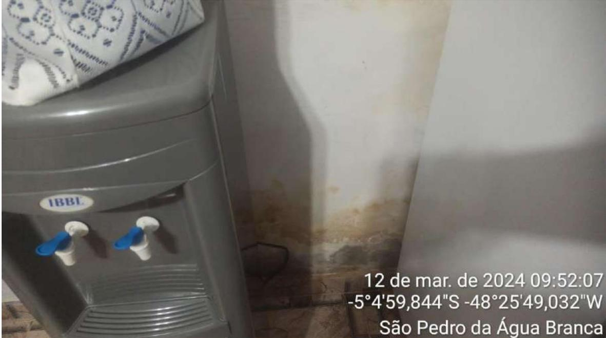
Copa/cozinha – Infiltração por umidade ascendente
