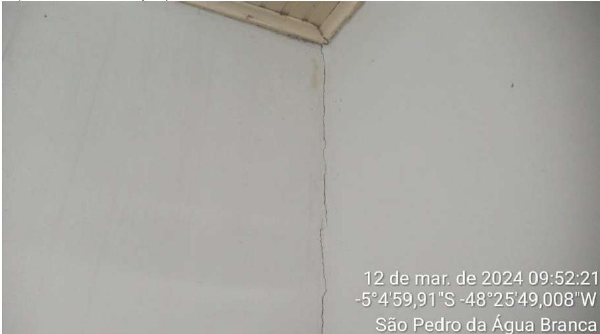
Copa/cozinha – Trinca na união das paredes
