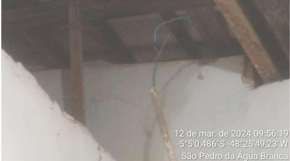
Fiação de ligação da bomba em cano de água
