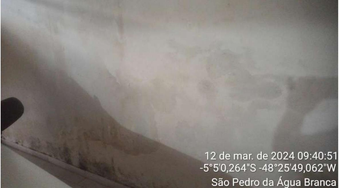
Garagem – Infiltração na parede lateral
