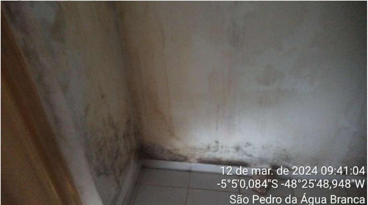
Garagem – Infiltração na parede lateral
