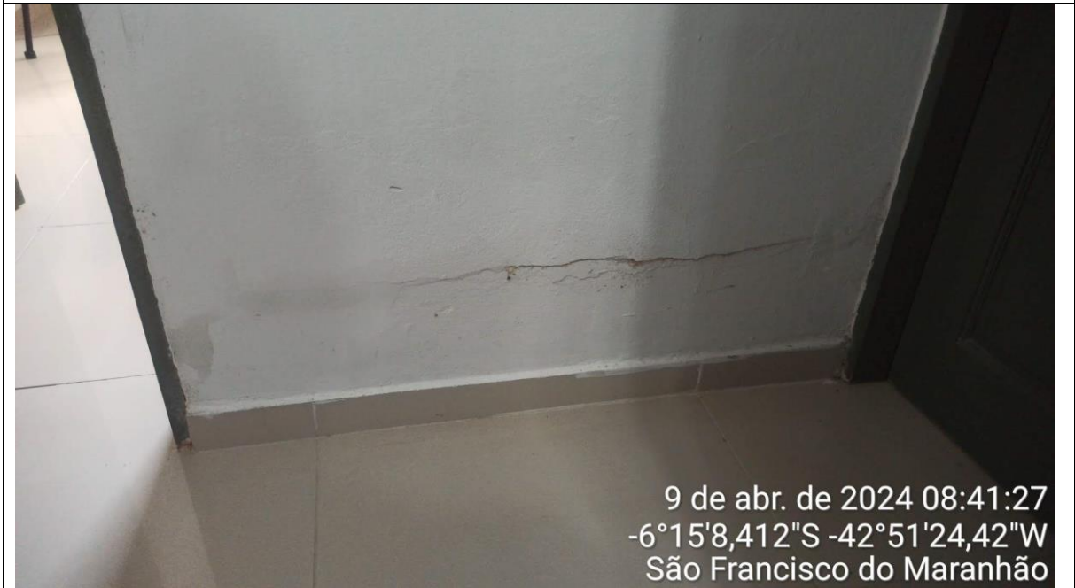
Pintura deteriorada
