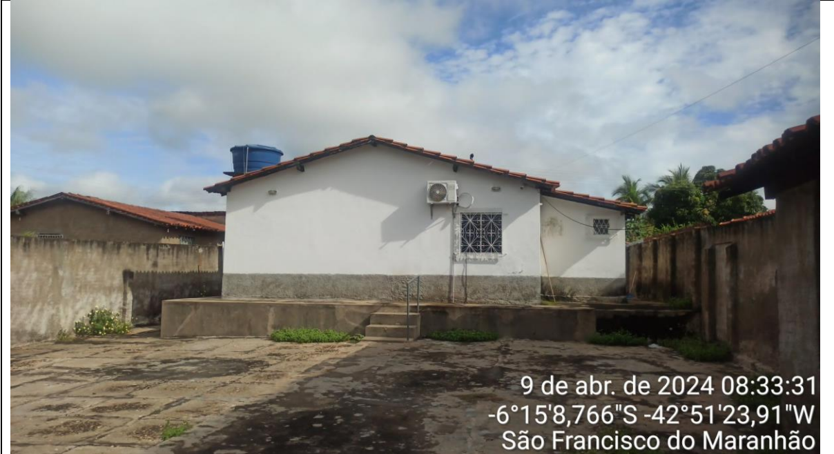
Vista dos fundos da edificação
