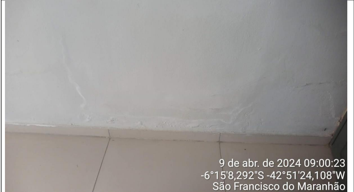
Parede da cozinha umidade
