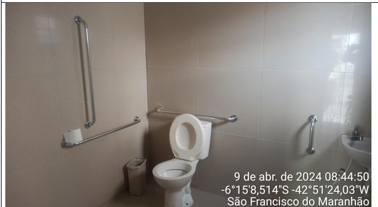
Barras de apoio adequadas à NBR 9050:2020
