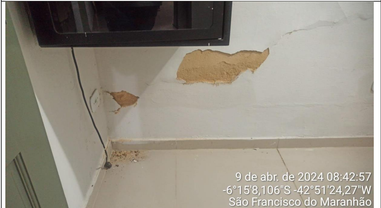
Pintura deteriorada
