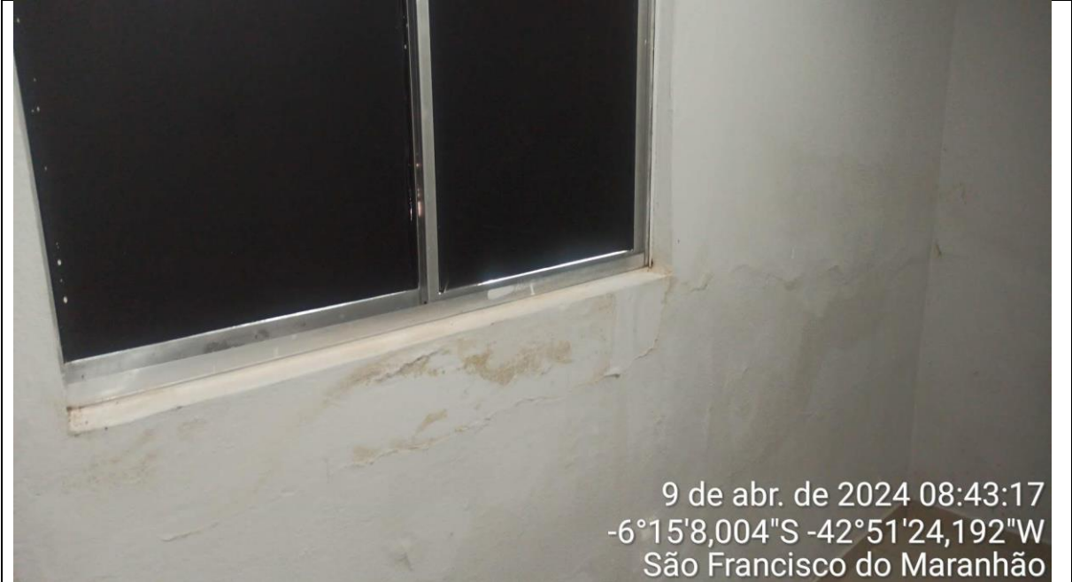
Infiltração em sala de rack
