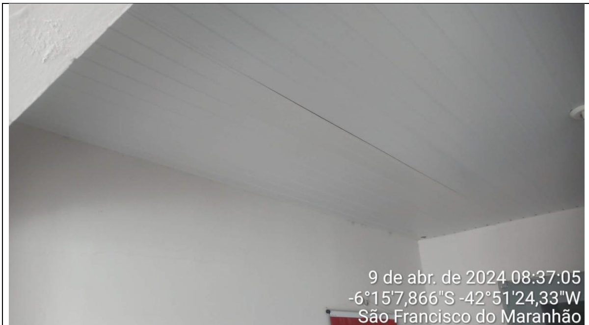
Forro da recepção (régua deslocada)
