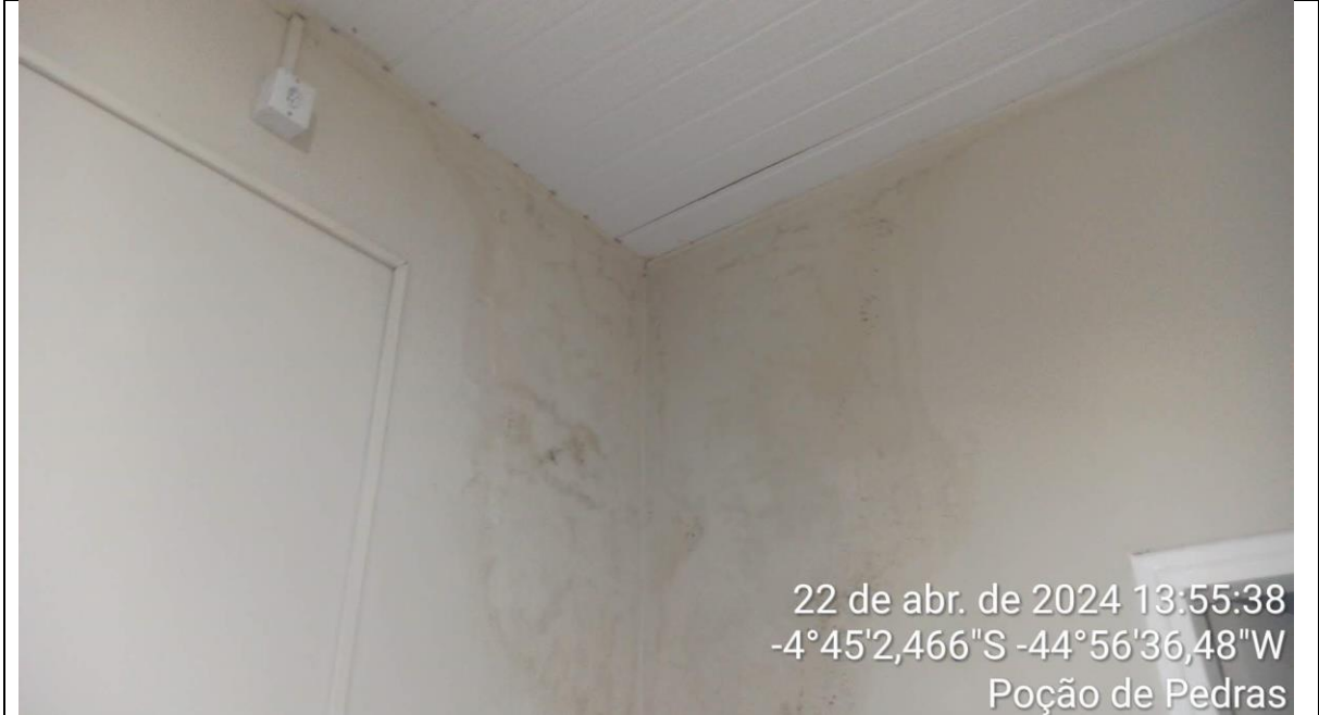
Infiltração a partir do teto
