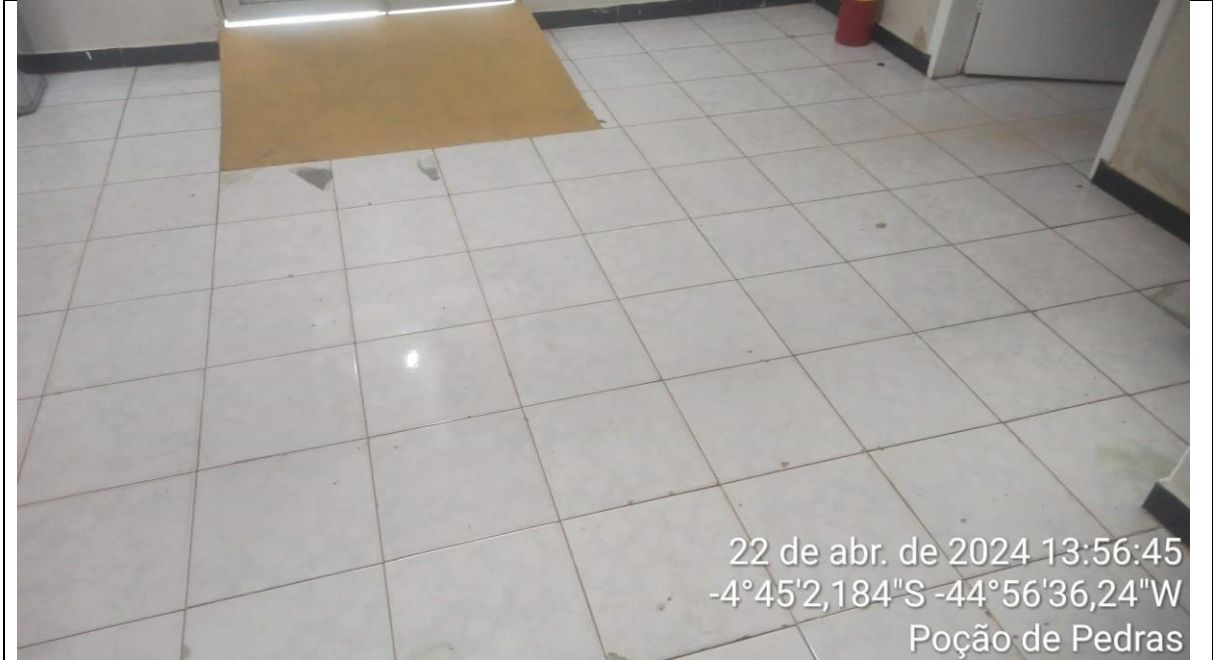
Rampa interna e piso da recepção
