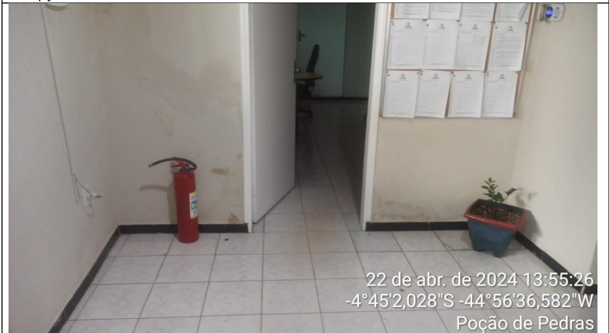
Paredes com manchas de infiltração
