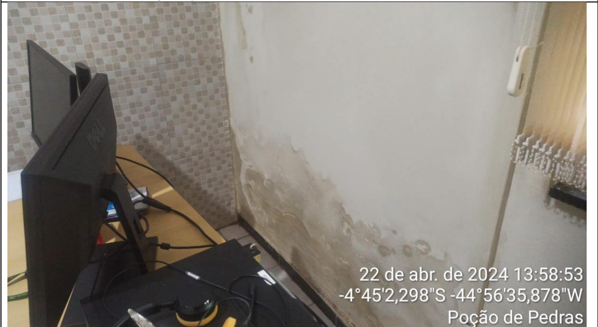
Sala de servidores infiltração por umidade ascendente
