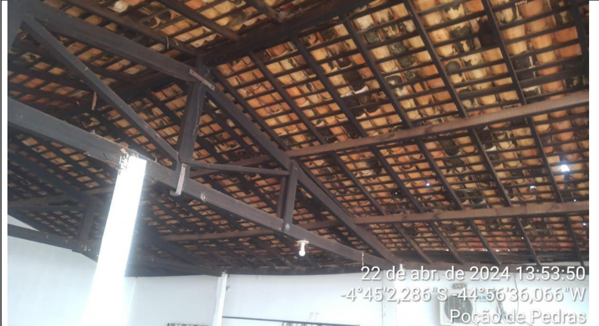
Cobertura da garagem
