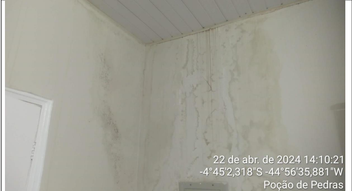
Sala da assessoria infiltração a partir do teto
