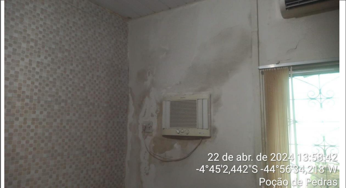
Sala de servidores infiltração a partir da cobertura
