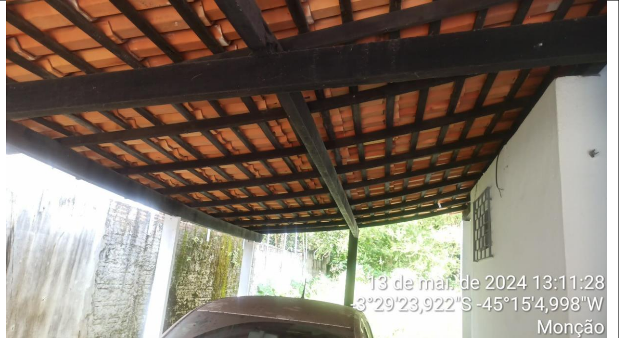
Cobertura da garagem
