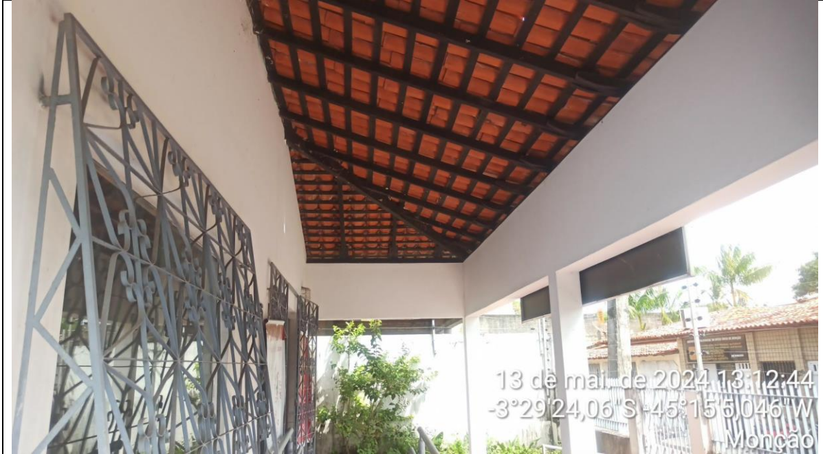
Cobertura da Varanda
