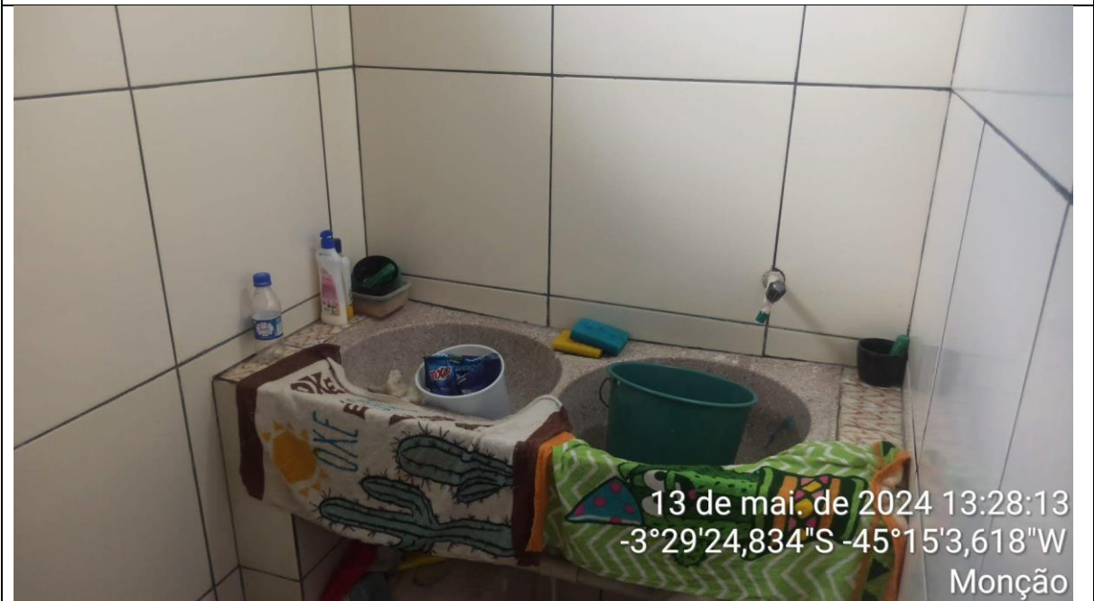
Banheiro Masculino (área de serviço)
