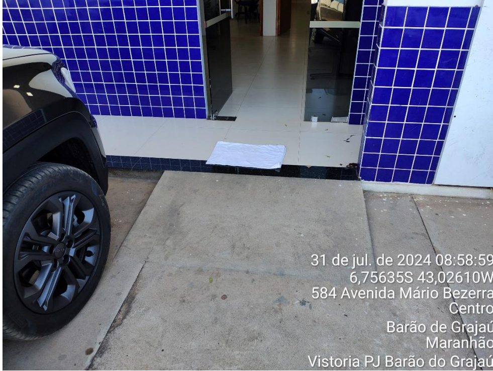
Foto 3 - rampa de acesso da porta frontal;
