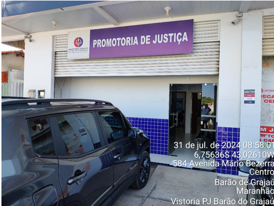
Foto 1 - Fachada do imóvel
