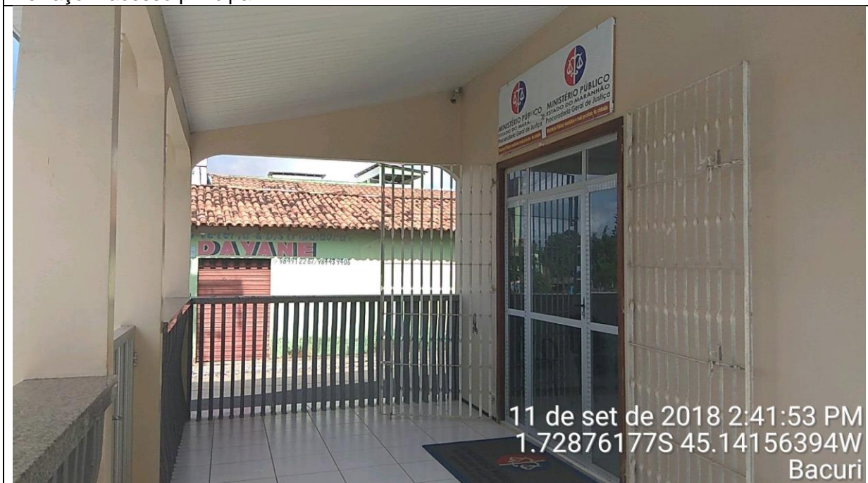
Terraço – acesso principal
