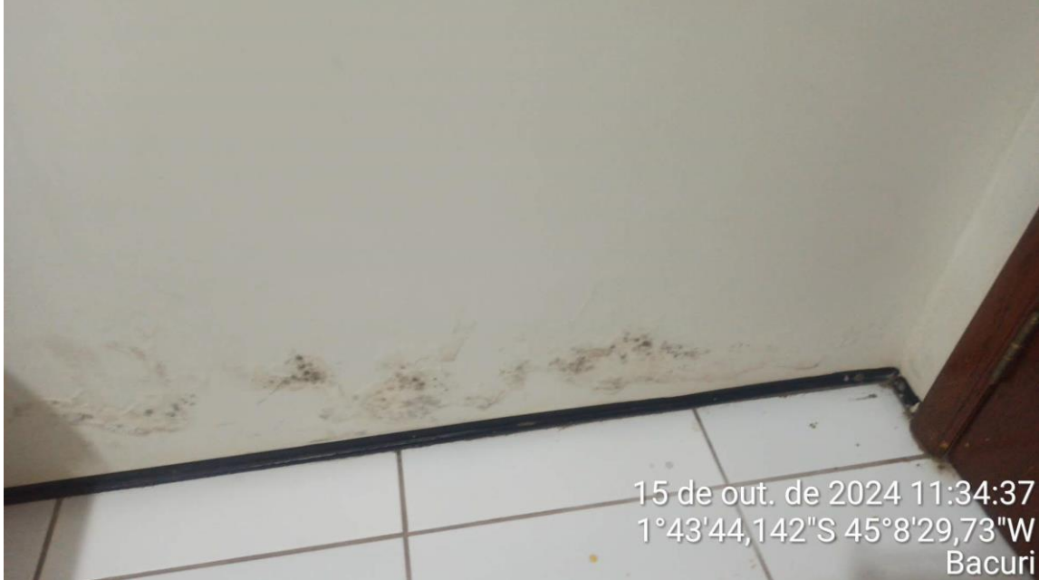
Gabinete – bolor devido umidade ascendente
