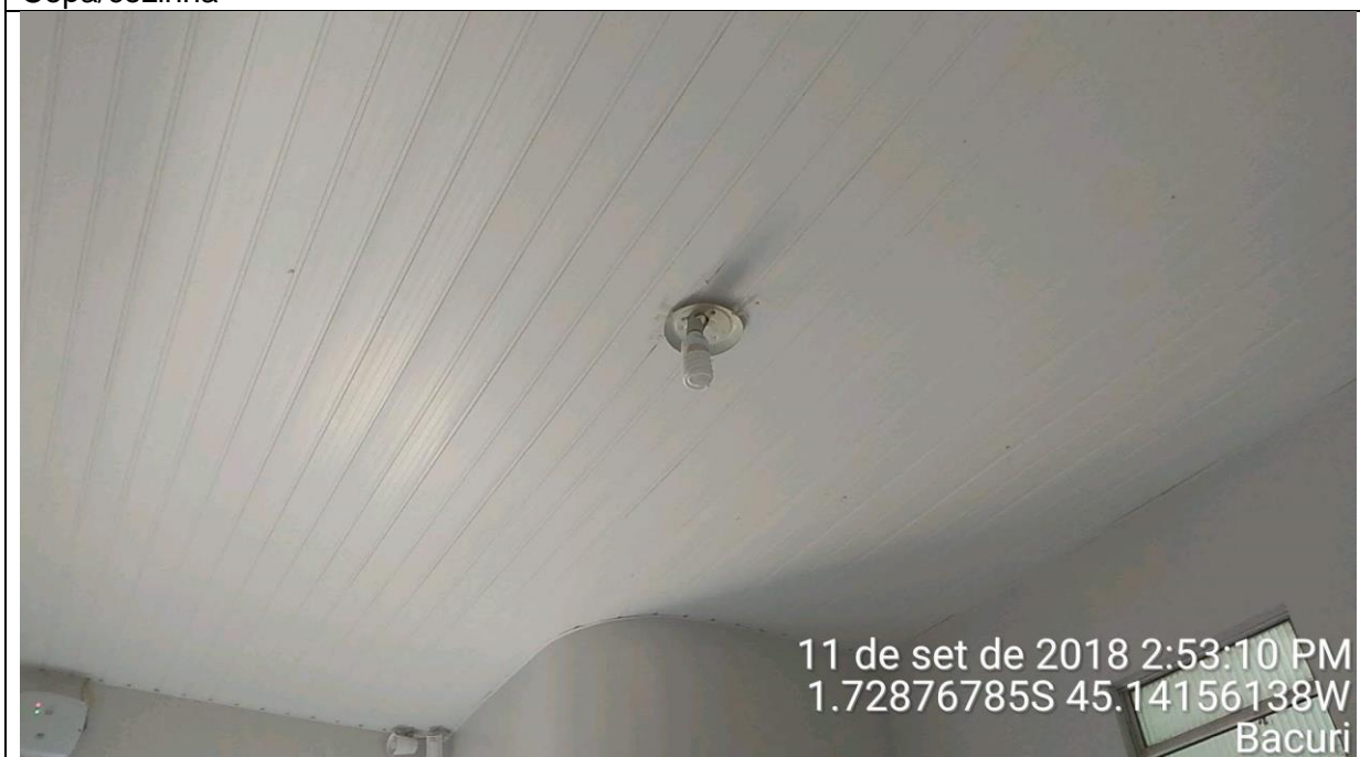
Forro da copa/cozinha
