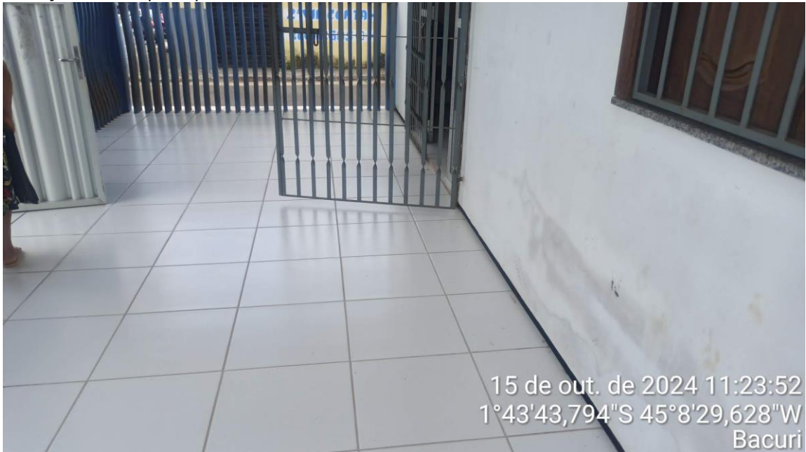
Terraço – acesso principal
