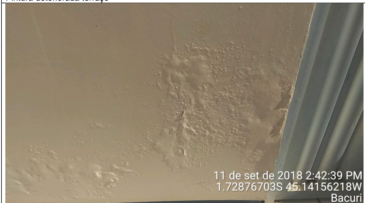
Pintura deteriorada terraço
