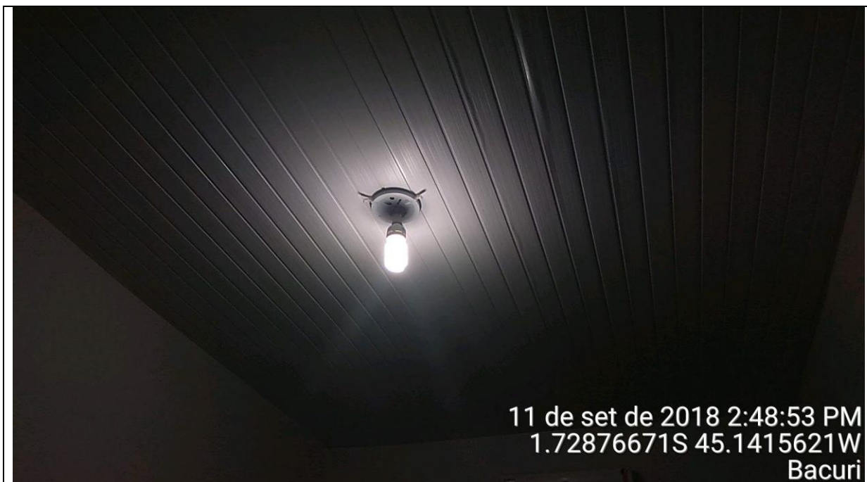
Lampada inadequada à luminária – gabinete 03
