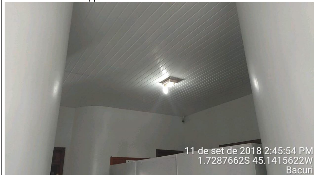
Forro sala 02 – lâmpada inadequada
