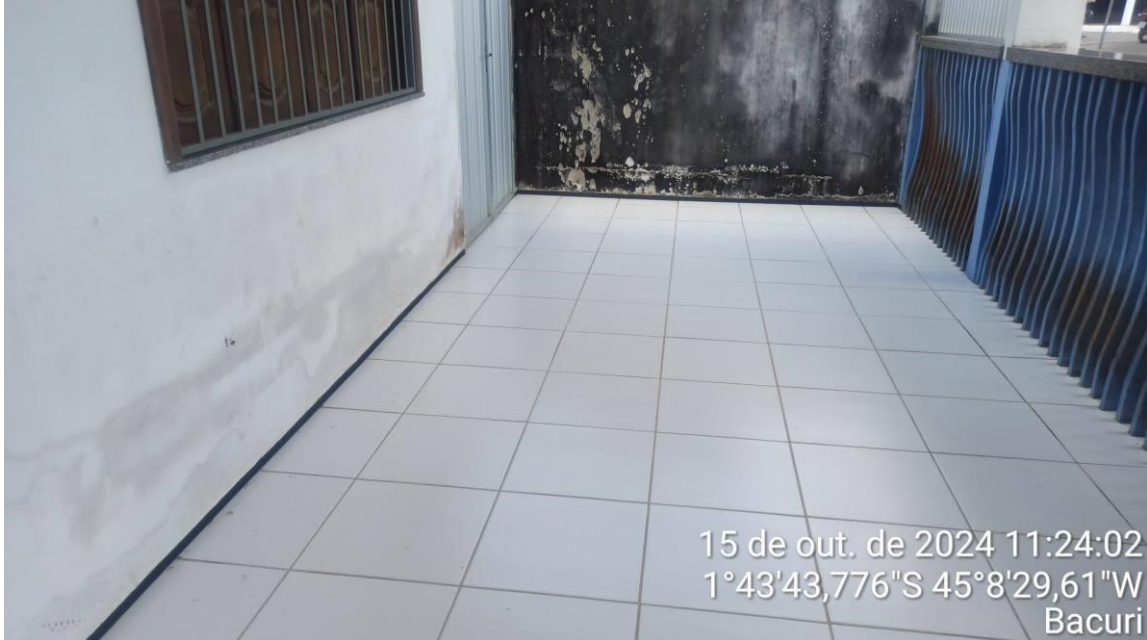
Pintura deteriorada terraço
