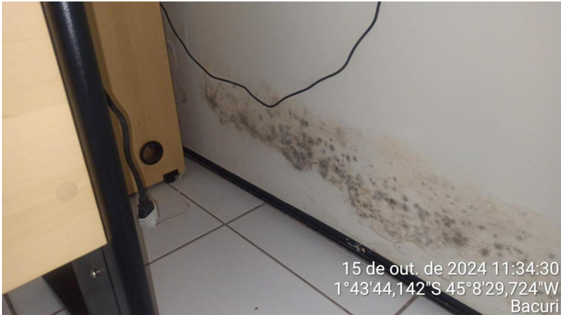
Gabinete – bolor devido umidade ascendente
