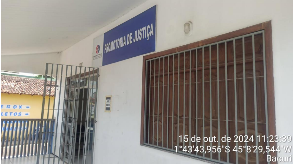
Terraço – acesso principal
