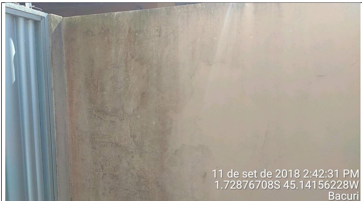
Pintura deteriorada terraço
