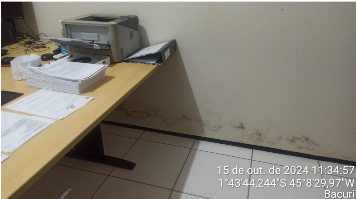
Gabinete – bolor devido umidade ascendente
