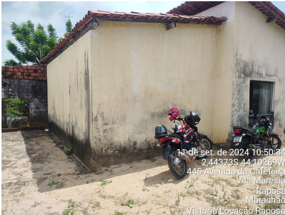
Foto 2 – Fachada interna do imóvel
