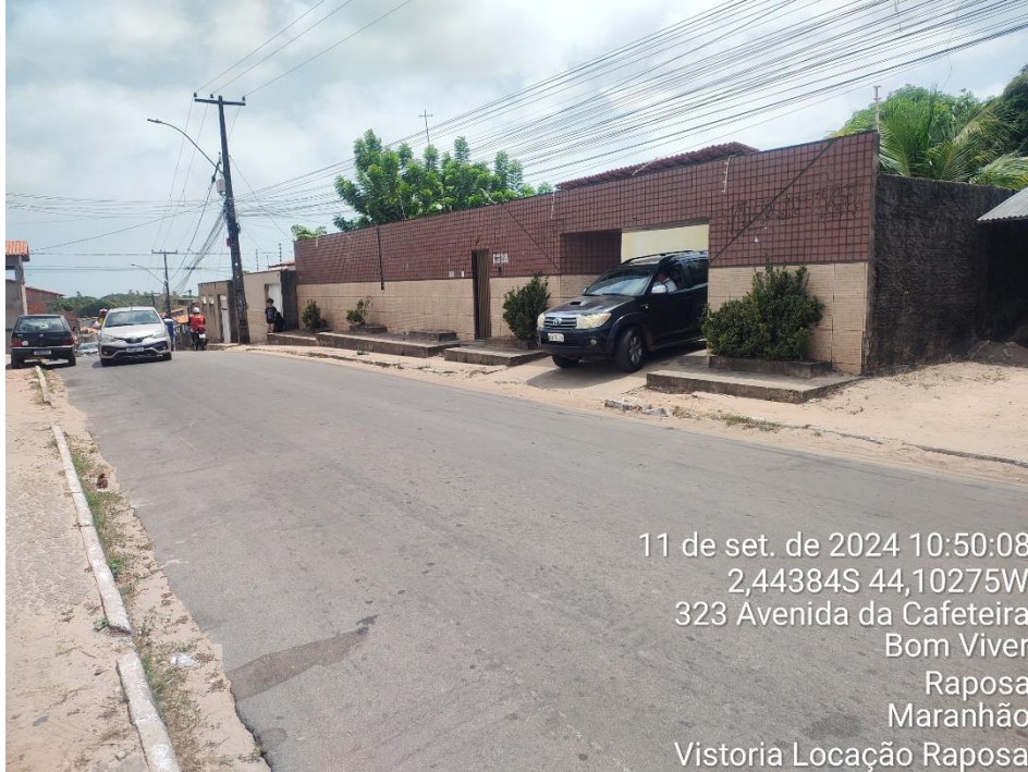
Foto 1 – Fachada externa do imóvel
