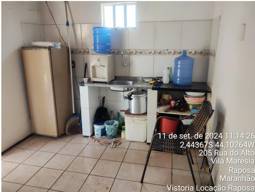
Foto 14 – Cozinha com cerâmica apenas a meia altura;
