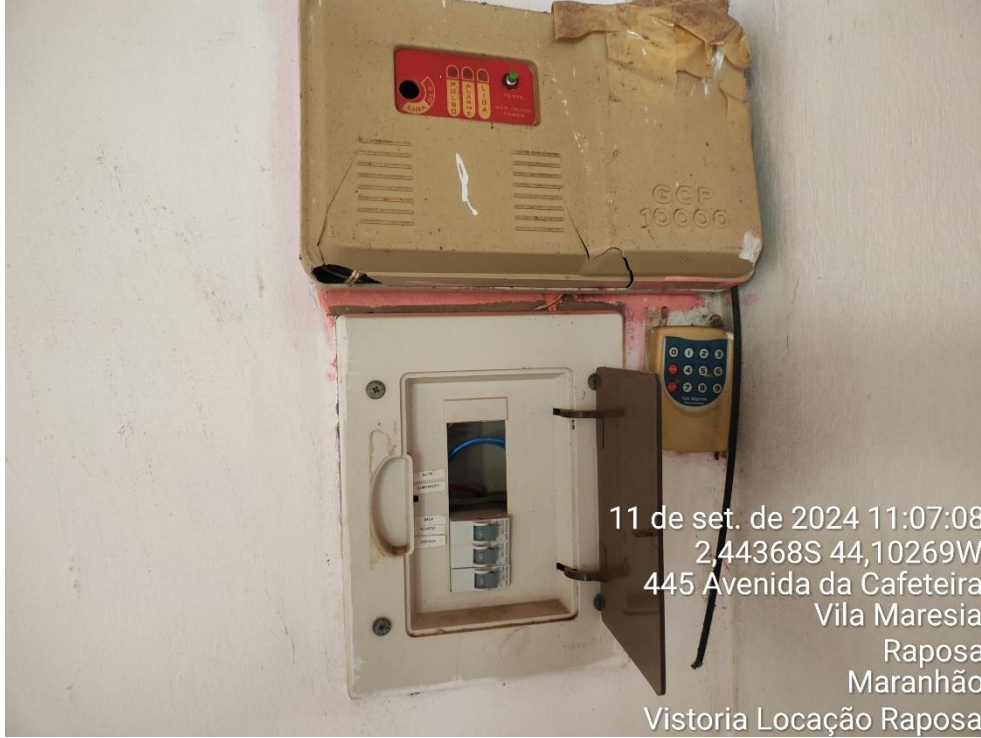
Foto 11 – Quadro de distribuição elétrica deficiente para receber a sede da Promotoria de Justiça
