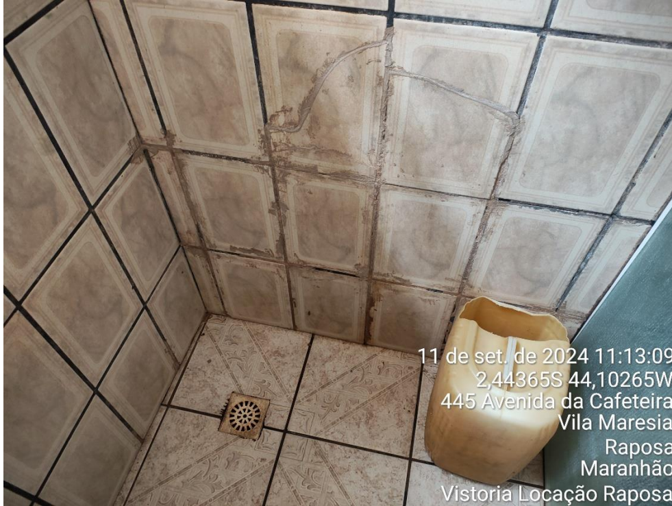
Foto 19 – Cerâmica de parede quebradas para reparo
