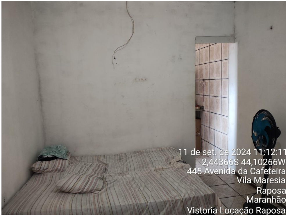
Foto 16 - Gabinete com banheiro sem porta;
