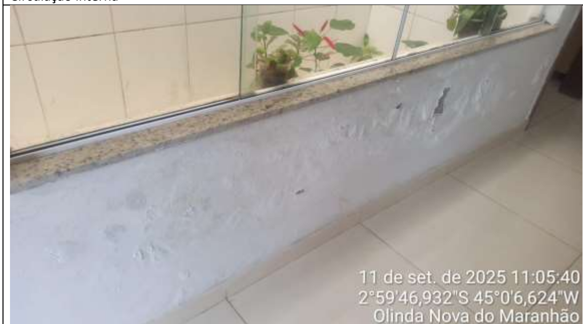
Circulação interna – pintura deteriorada
