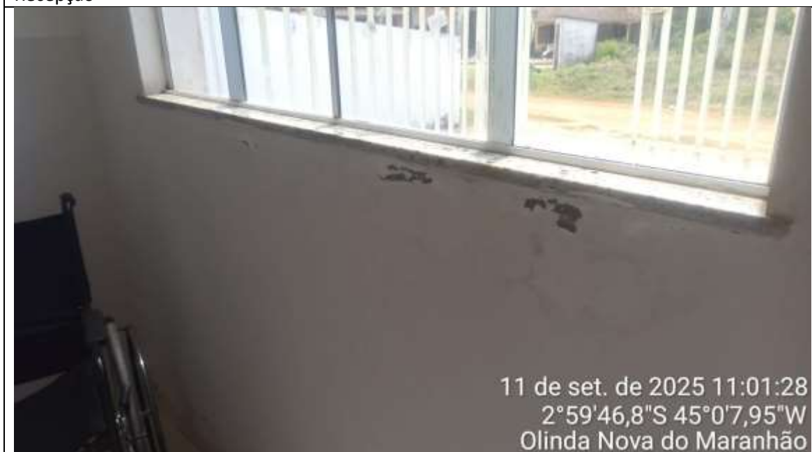
Recepção – pintura deteriorada
