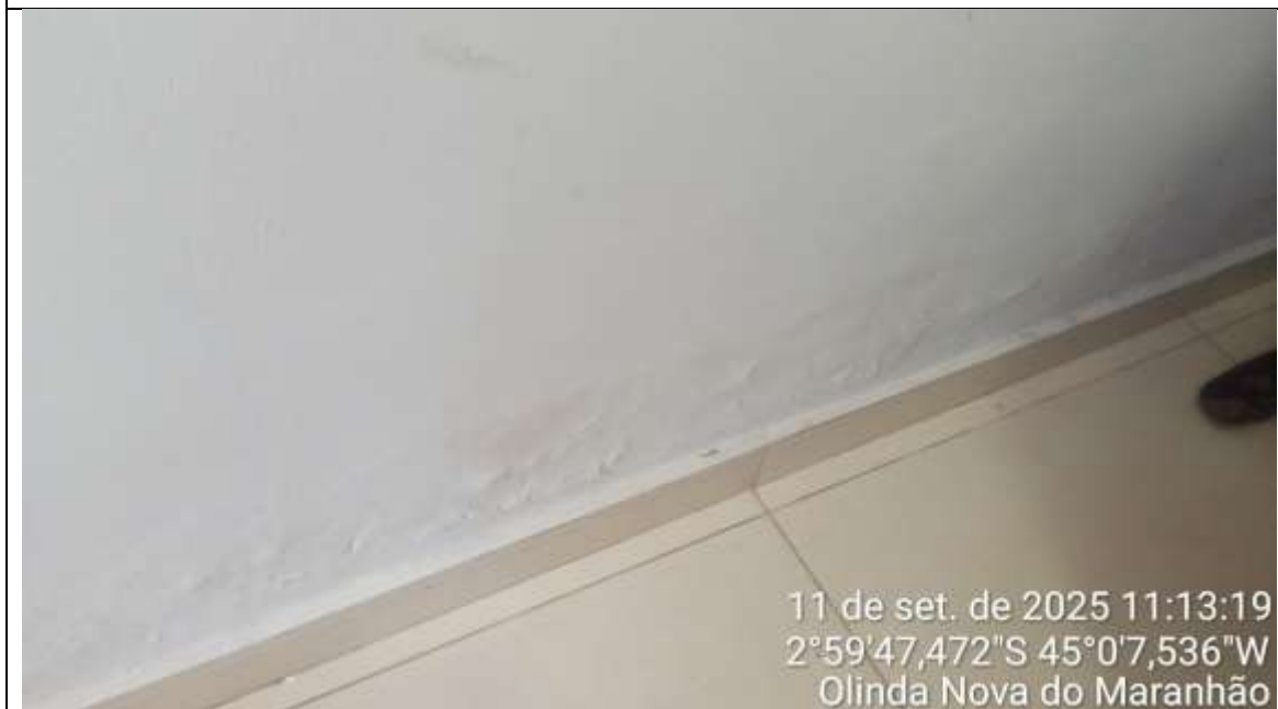
Sala de atendimento – pintura deteriorada
