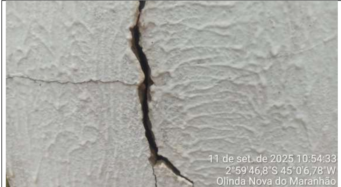
Rachadura em muro divisorio
