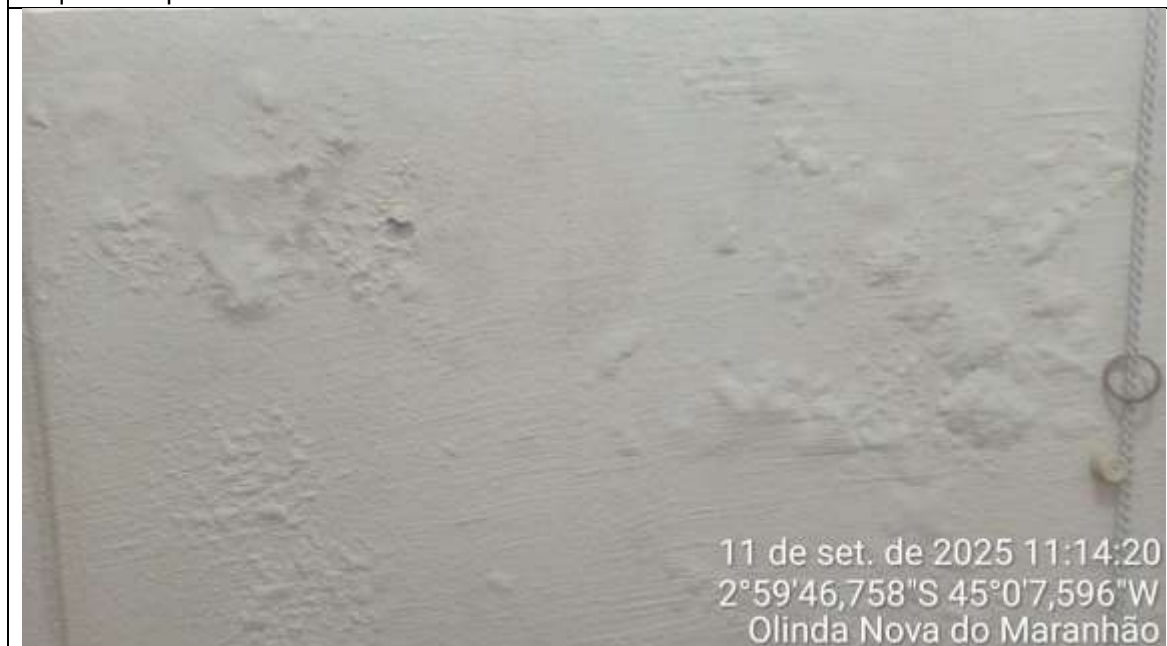
Arquivo 1 – pintura deteriorada
