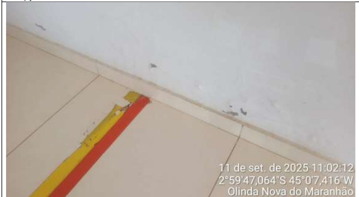
Recepção – Pintura deteriorada
