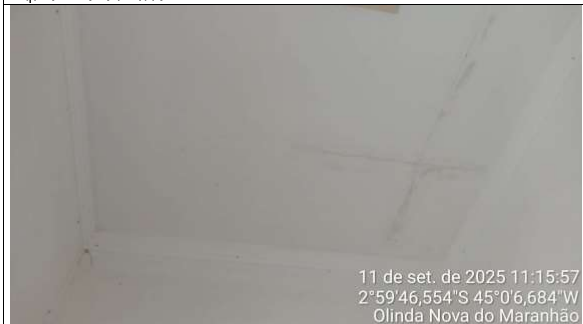
Arquivo 2 – Forro trincado
