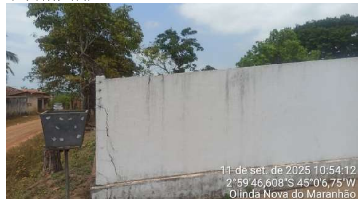
Rachadura em muro divisório
