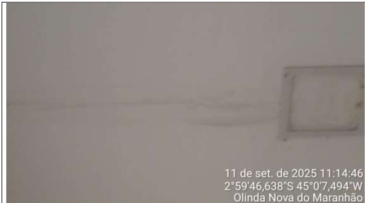
Arquivo 1 – forro trincado
