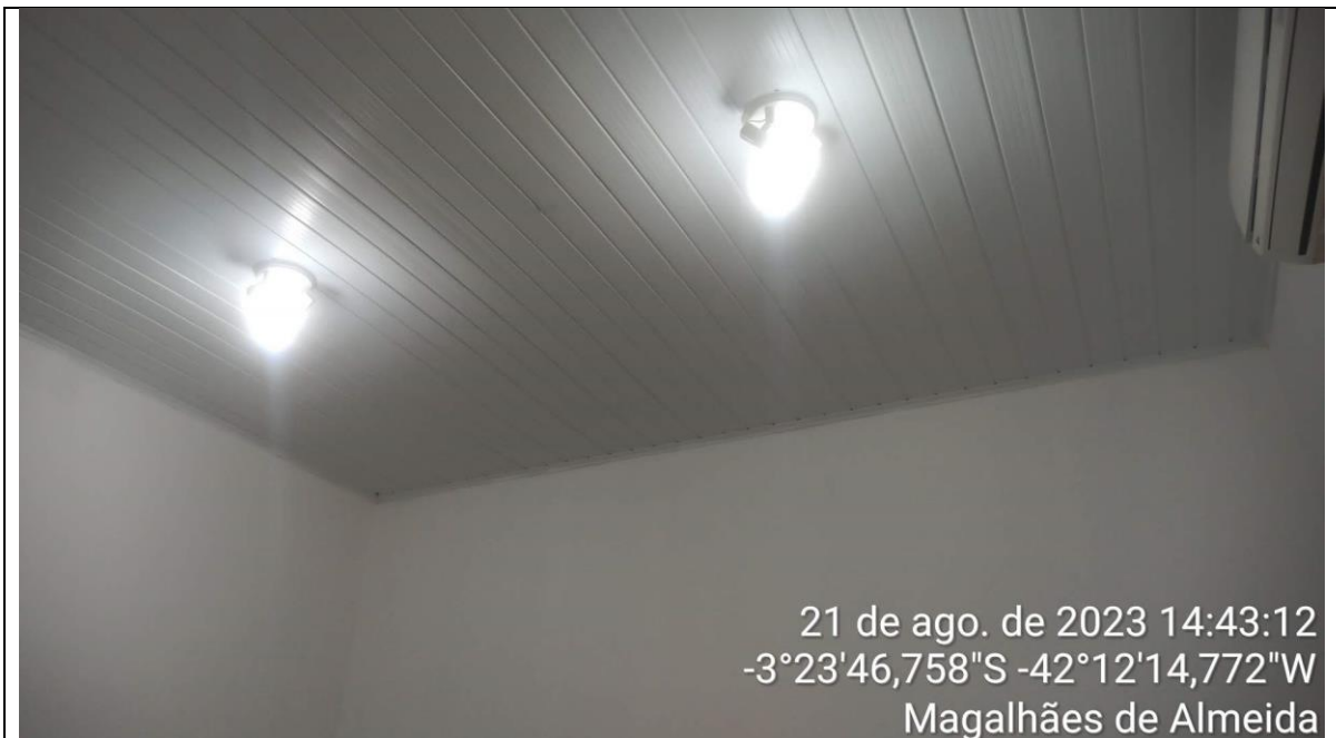
Sala de assessoria
